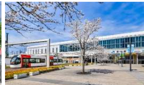
■路面電車南北接続
