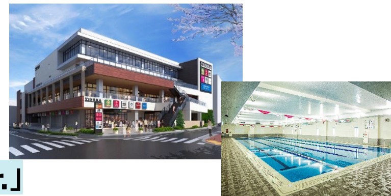
スポーツクラブと介護リハビリ施設を併設する「ルネサンス蒔田」
