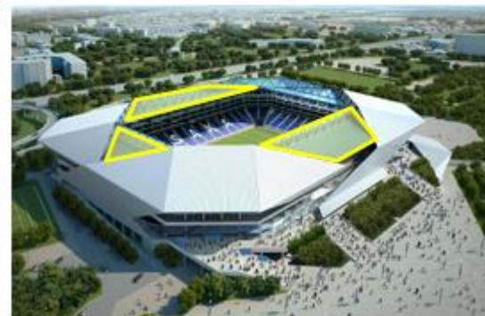
太陽光発電設置場所
