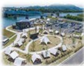
賑わい拠点の整備 (木曾川/美濃加茂市)
