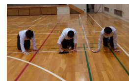
柔らかい布を使用した床板の点検方法の例
