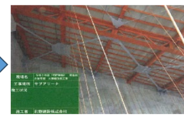
耐震対策後 (屋根のブレース補強)
