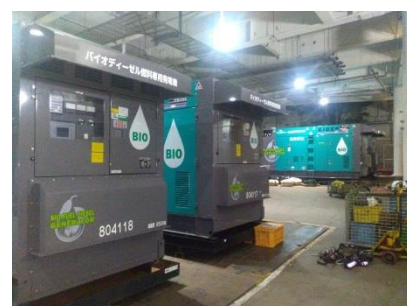
バイオ燃料を使用した仮設発電機
