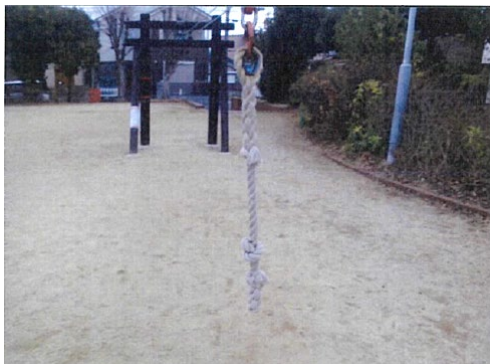
滑車部に指を挟む損傷：滑車からロープ下端までの長さが940mm (遊具の安全に関する規準：1,750mm)
