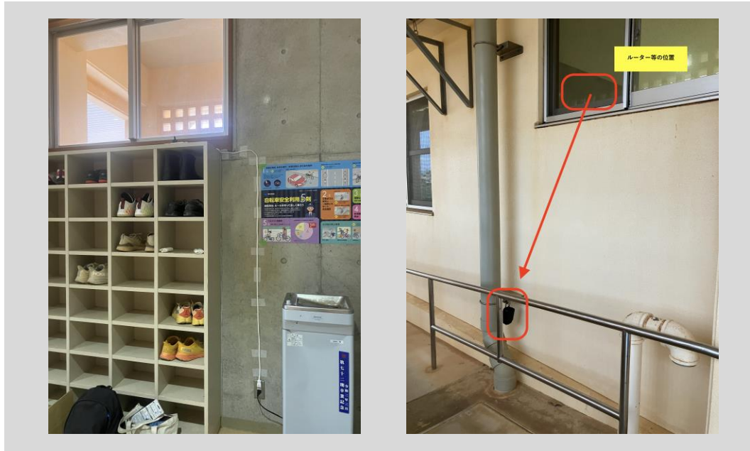
【スマートキーボックス設置状況】
