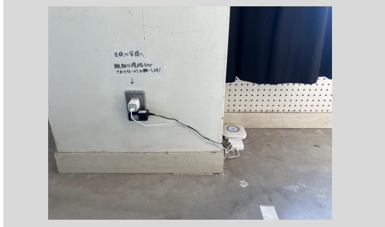
【スマートキーボックス設置確認】
