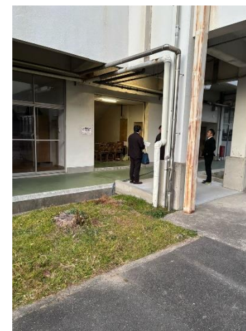
【音楽室導線確認】
