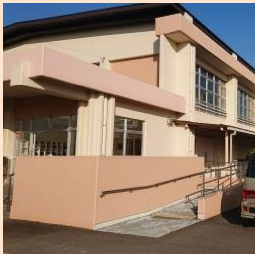
外からの車いすスロープの設置
