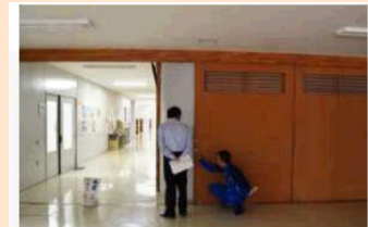
開放部分を仕切るための扉
