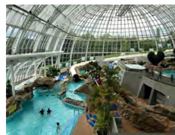
改修前の様子
