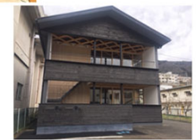
〈徳島県三好市：遊休施設となっていた林業研修センターを改修（マチの棟）〉
