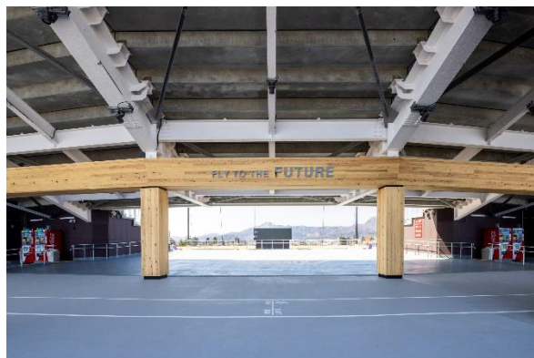
観客出入口ゲート(盛岡市産材)
