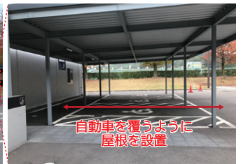
・後方から乗降する福祉車両でも濡れないよう屋根を設置
