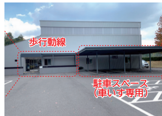
・車いす利用者用駐車場および入口までの動線に屋根を設置
