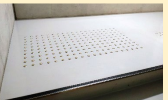
点状ブロック設置
