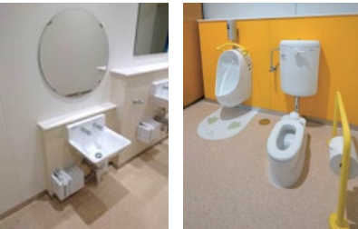
洗面の高さを1カ所低く設置。多機能トイレの混雑を防ぐため、男女トイレに幼児用ブースを設置し、子ども連れに配慮した器具を充実。
