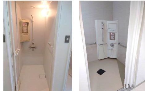
男女シャワー室において、車いす利用者も旋回しやすい広さを確保。(幅800mm×奥行1,200mm)
