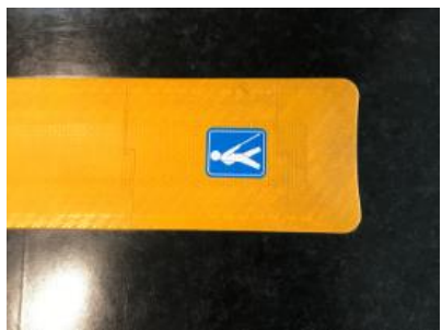
利用者の障壁とならず、かつ視覚障害者がわかる点字ブロックを採用。
