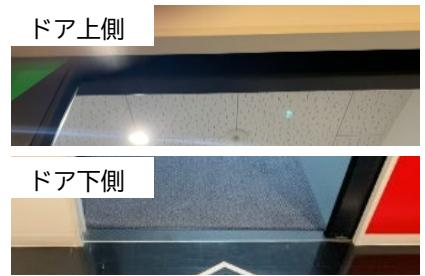
車いす利用者が安心して通ることができるように、上吊り引き戸とすることによって、下の段差を解消。
