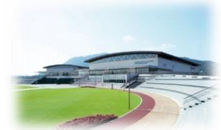
スポーツ施設を核とした活性化
