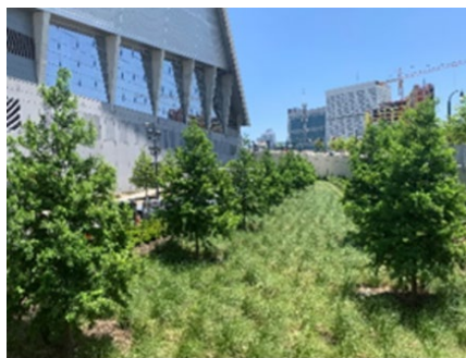
雨水を収集する機能を持つ景観
