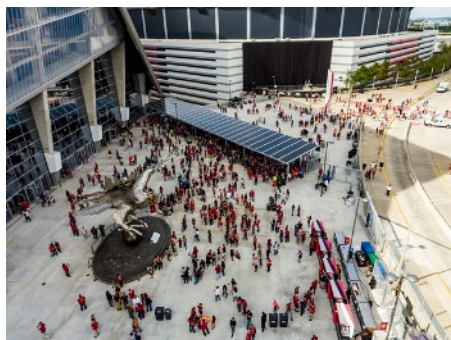
建物前に設置されたソーラーパネル
