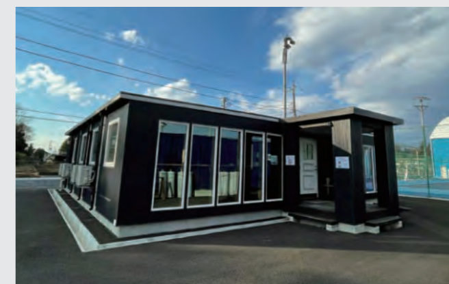
整備した境町アーバンスポーツパーク及び SAKAI Tennis court 2020のクラブハウス
