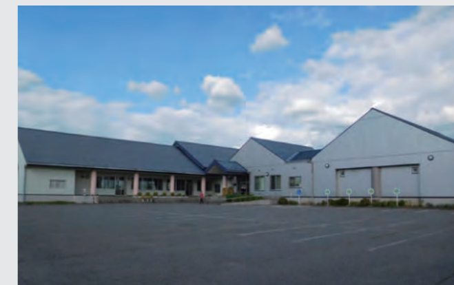
改修した公民館(まちづくりセンター)
