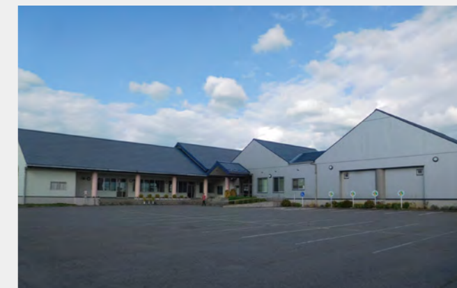
改修した公民館
