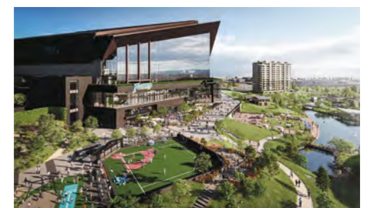
2023春に向けて建設が進む「北海道ボールパークFビレッジ」都市公園制度の柔軟な運用により実現されるのは民間セクターによるウェルビーイングなまちづくり拠点そのもの ©H.N.F
