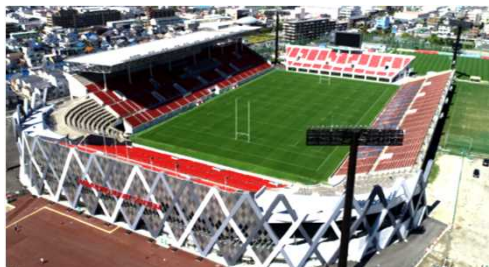
Park-PFIによるラグビー場の再整備 【花園中央公園（東大阪市）】
