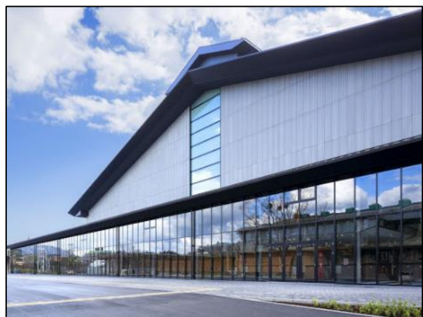
松江市総合体育館
