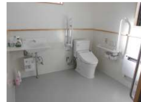
新設された多目的トイレ
