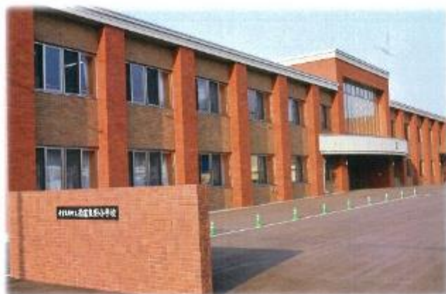
南富良野町立南富良野小学校
