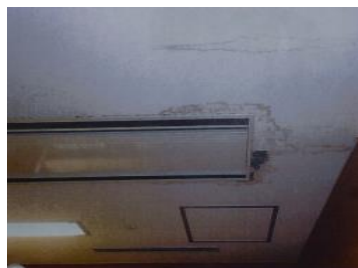
【空調設備(ファンコイル)】
