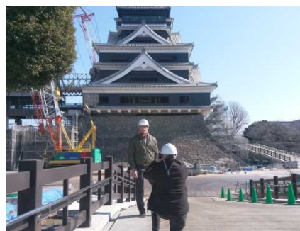
復旧中の熊本城視察
