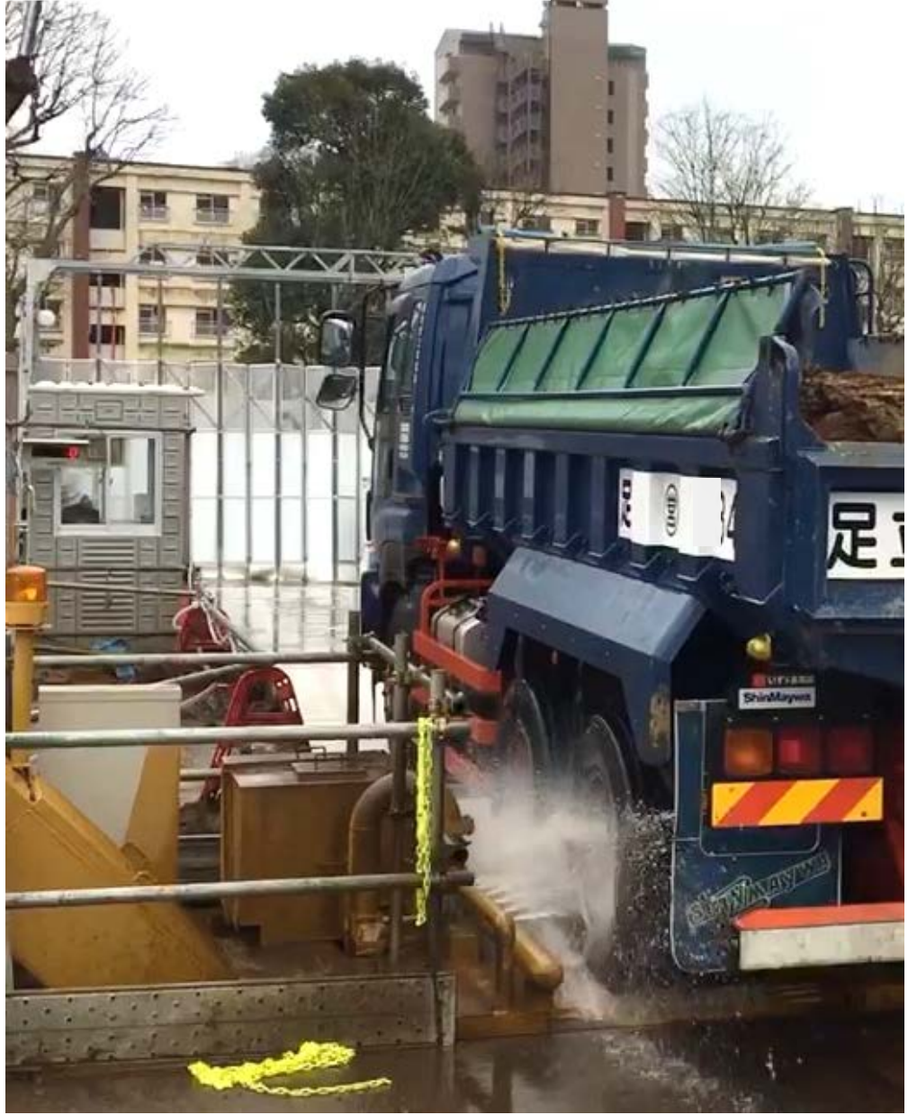
6 土砂運搬車輛のタイヤ洗浄
