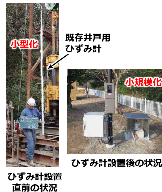
既存の未使用井戸の活用による小口径ひずみ計の埋設
