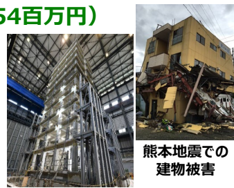
実大三次元震動破壊実験施設 (E-ディフェンス) 熊本地震での建物被害
