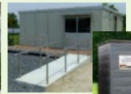
休憩所、トイレの整備
