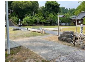
▼地震による被害（鳥居の倒壊）
