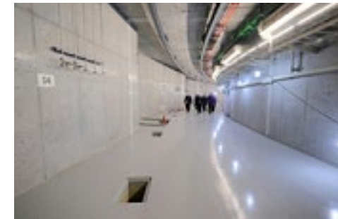
蓄積リングトンネル
