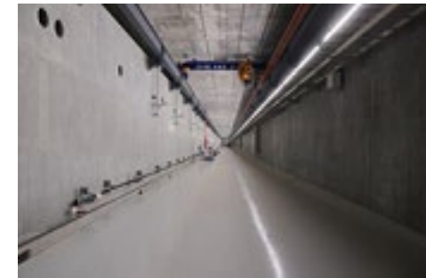
ライナックトンネル
