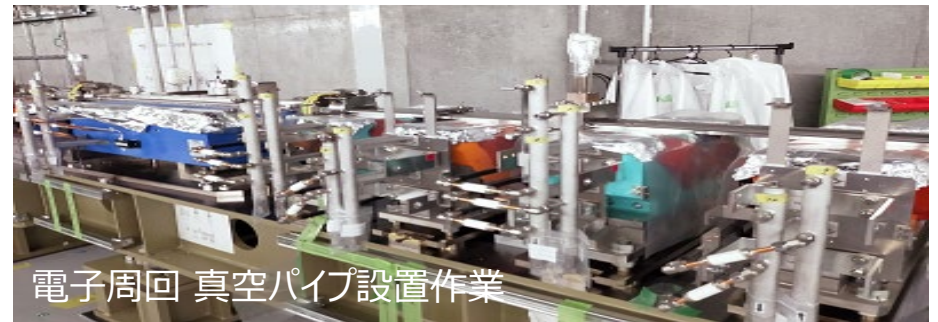
蓄積リング設置 電磁石セル (偏向電磁石、四極・六極電磁石)
