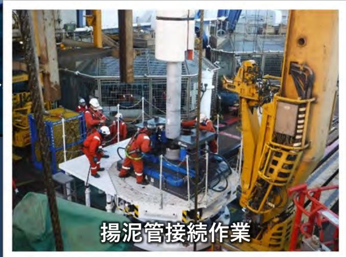
→ SIP第2期でレアアース生産のために新たに設計・製作した揚泥管、簡易揚泥管、接続管、各種ツール等のハンドリング試験を実施し、各機器の機能・健全性を確認。
