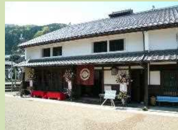
(伝統的な家屋の宿泊施設への転用)
