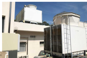
屋上に設置した冷却塔からの漏水により、中央熱源設備が機能停止
