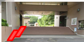
現在階段のみ、スロープ設置
