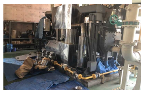
屋上に設置した冷却塔からの漏水により、中央熱源設備が機能停止
