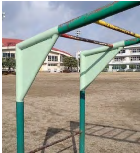
写真30 開口部を全て埋めた対策例
