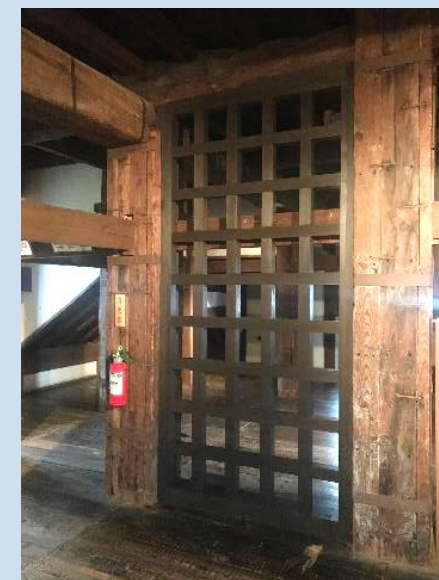
耐震補強・三階の木製格子壁
