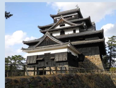
松江城天守外観
