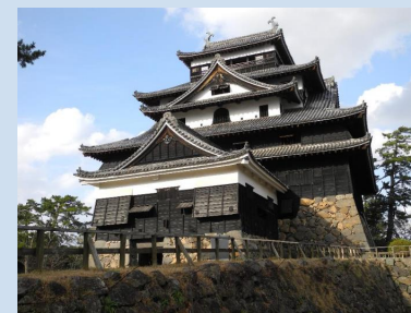
松江城天守外観
