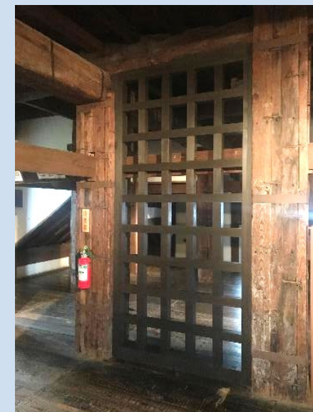
耐震補強・三階の木製格子壁
