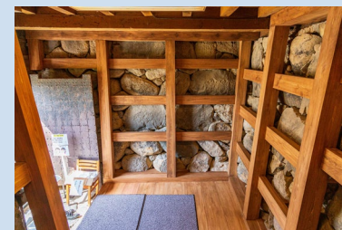
安全対策・附櫓内部穴蔵の木格子
