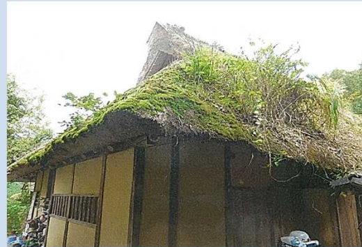
修理前（南東から）
