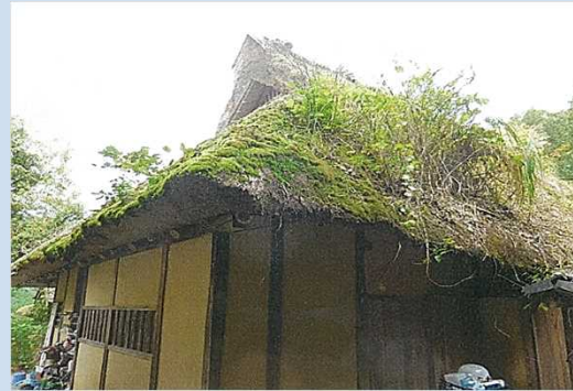
修理前（南東から）
