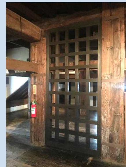
耐震補強・三階の木製格子壁
