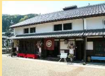
(伝統的な家屋の宿泊施設への転用)
