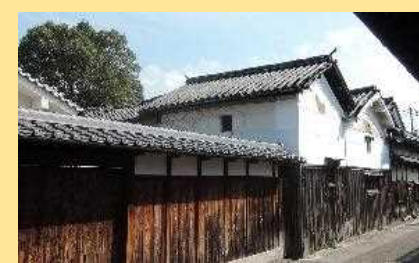
(伝建地区の美観向上 (外壁漆喰の塗りなおし))
