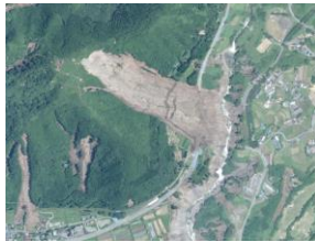
災害時の空中写真
