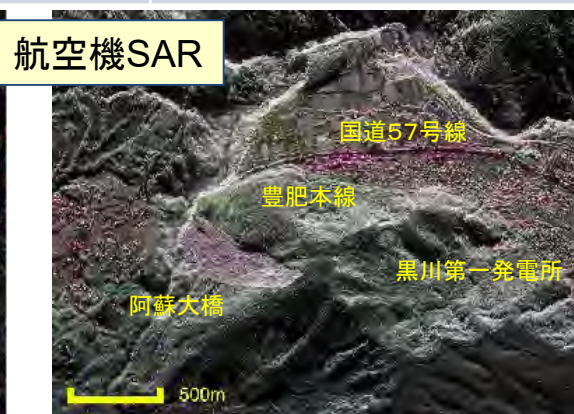
地表面状況の高分解能偏波観測
