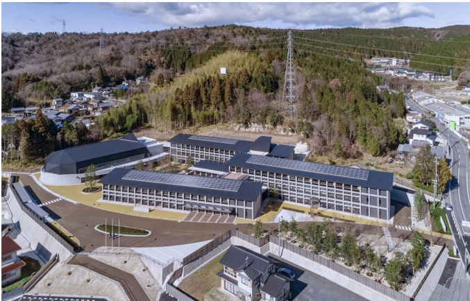
上空からの校舎全体の様子
