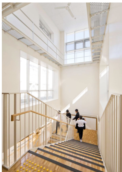
「風の塔」となる階段室から天井を見上げた様子
