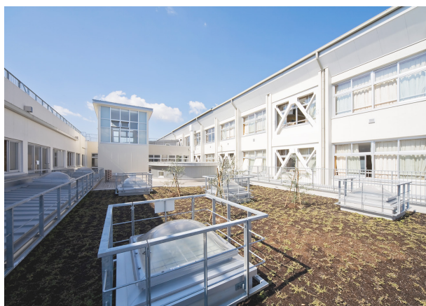
改修により新しく設置された屋上スペース。中央奥の部分が風の塔。
