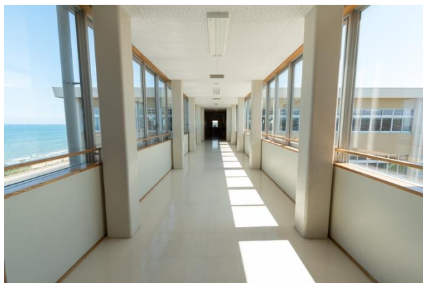
校舎間をつなぐ渡り廊下（新設）。
