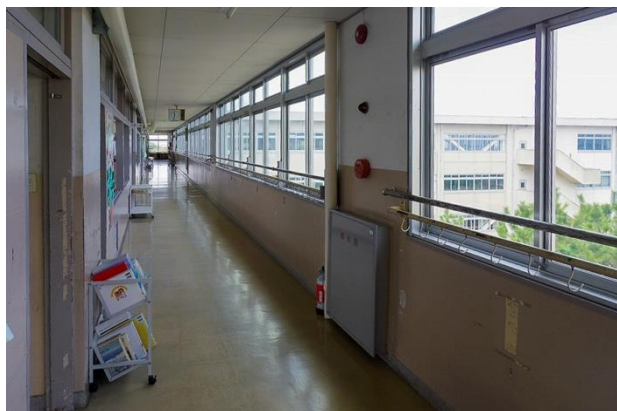
改修前の廊下の様子。
