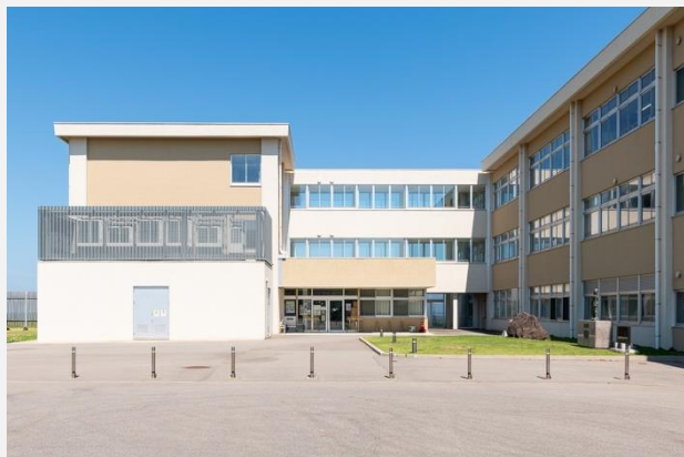
校舎間を繋ぐ渡り廊下が、2階3階部分に新設された（写真中央）。1階部分は学童玄関がある。
