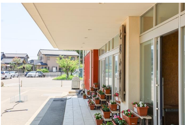
既存校舎の庇を延長し、玄関アプローチを整備
