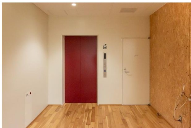
エレベーターを新設。
