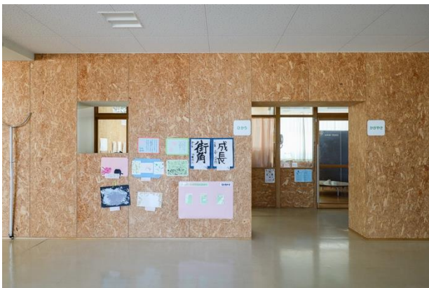
既存の鉄骨ブレースを木質仕上げで覆い、教室前に小スペースを設けた空間。
