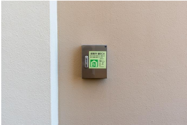
体育館玄関に設置された鍵BOX。災害時にはBOXが開き、地域の防災士が玄関を開けることができる。
