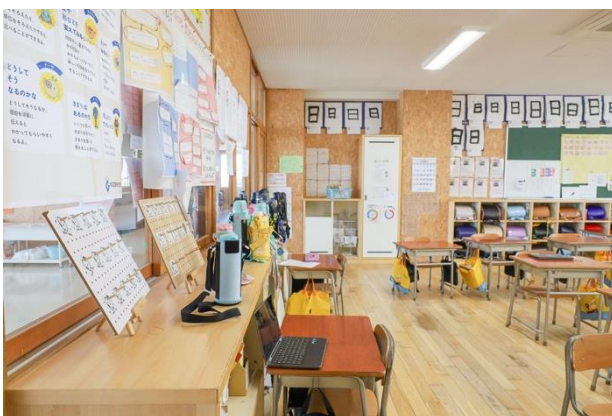
OSB合板を壁の仕上げ材として、教室内どこでも掲示が可能に。
