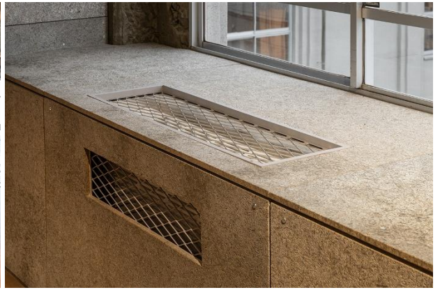
左) 天井部分のコンクリート現し。各部屋にライン照明を設置し、統一感を出している。 右) 空調設備は窓際に設置し、電気配線も可能な限り床下を通してしている。
