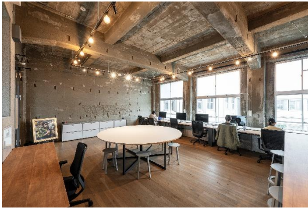
左) 天井部分のコンクリート現し。各部屋にライン照明を設置し、統一感を出している。 右) 空調設備は窓際に設置し、電気配線も可能な限り床下を通してしている。
