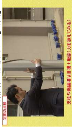
バックネット・防球ネット・ 掲揚塔の点検方法【動画】
