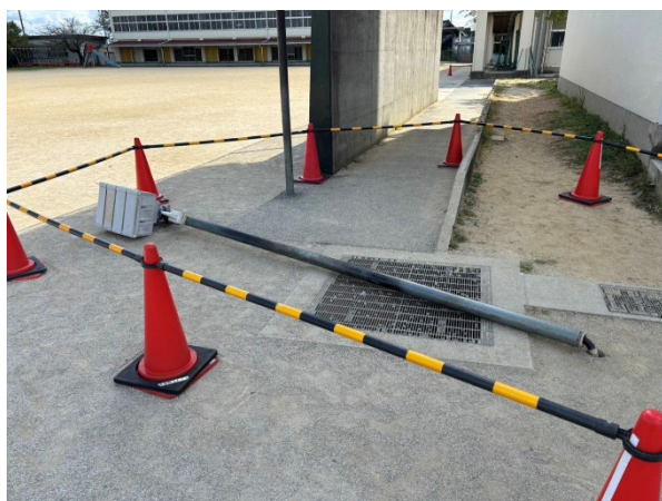
倒れたスピーカーの支柱
