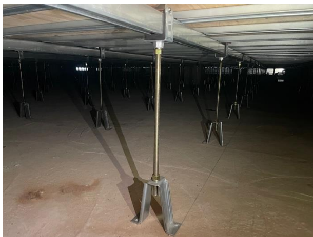
改修後の体育館の床下の様子。改修前は、鋼製床下地の老朽化が激しかった
