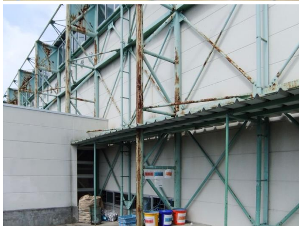
左上) 窓のない2階 右上) 下駄箱までに段差のある、押し戸の入り口 左下) 錆や色あせが見られる緑色のブレース
