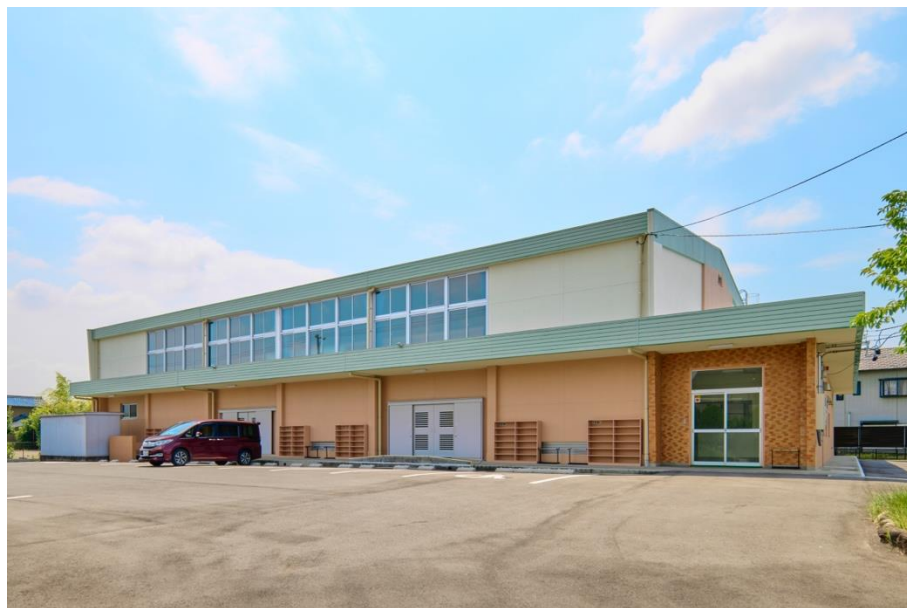
改修後体育館外観
