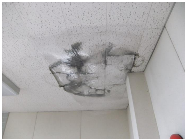
左上) 屋根には錆が目立つ 右下) 老朽化により雨漏りもあった
