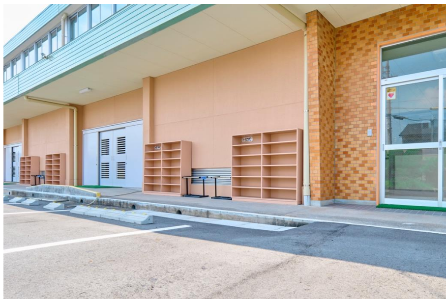
改修後の入り口の様子（下駄箱と入り口はスロープで繋がっている）
